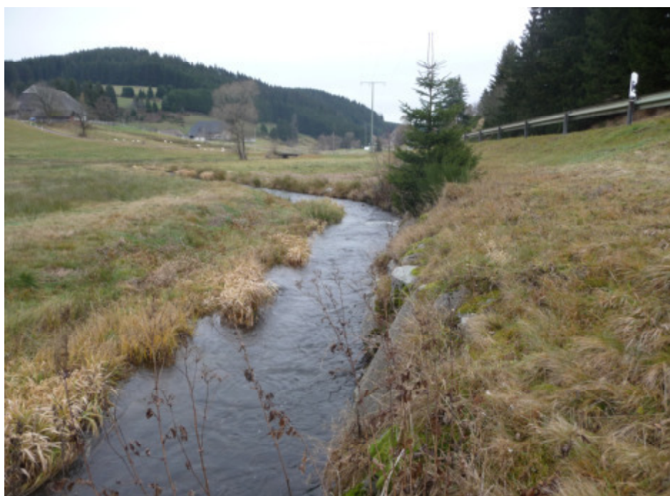
Fotos oben: Absturz im Rohrbach, vorhandener Graben der in Teilen zum Bachbett ausgebaut werden soll, Bestand verbauter Rohrbach neben der L 175
