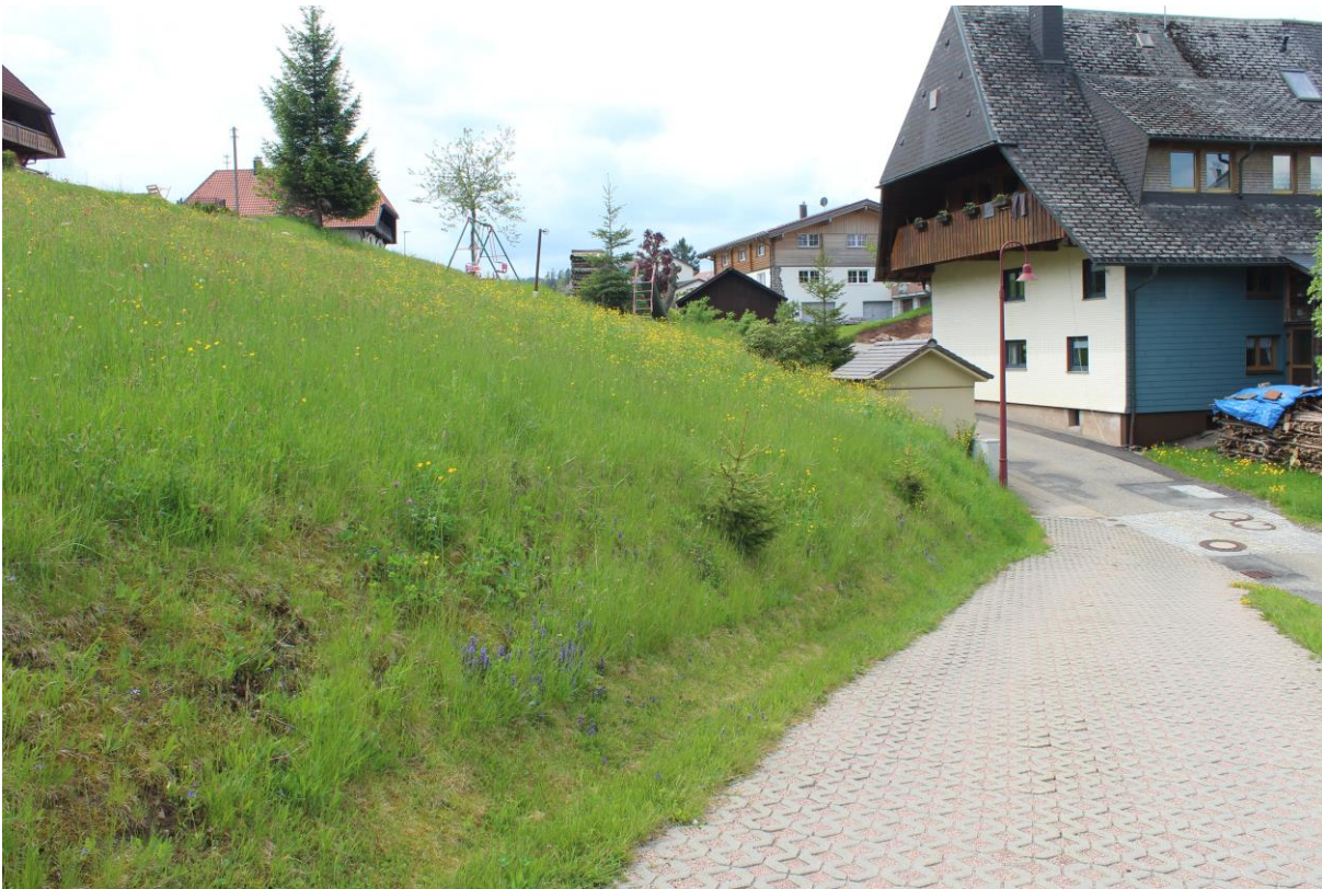
Bild 5: Zufahrtsweg Rasengittersteine mit Böschung, Blick Richtung Süden
